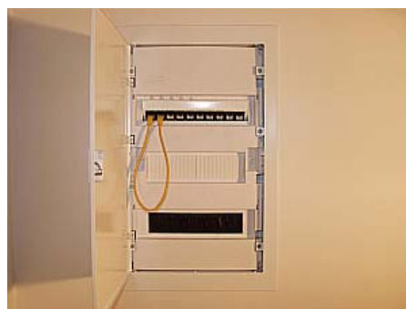
Obr. 3 – Bytové rozvaděče (dvou a jednokabelové) bez brány (dva / jeden přívodní (žluté) kabely)
