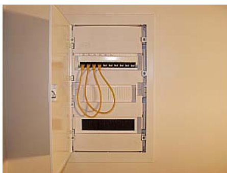
Obr. 3 – Bytové rozvaděče (dvou a jednokabelové) bez brány (dva / jeden přívodní (žluté) kabely)
